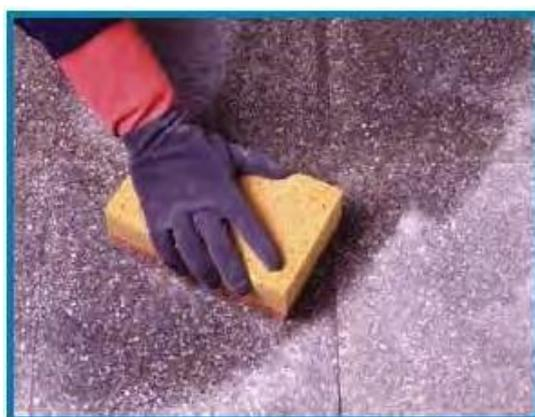
7. Seguidamente pasar una esponja humedecida con agua sobre la superficie empastinada y con un estropajo de dureza media (o esponja seca) emulsionar el producto con suaves movimientos circulares procurando no vaciar la junta.
