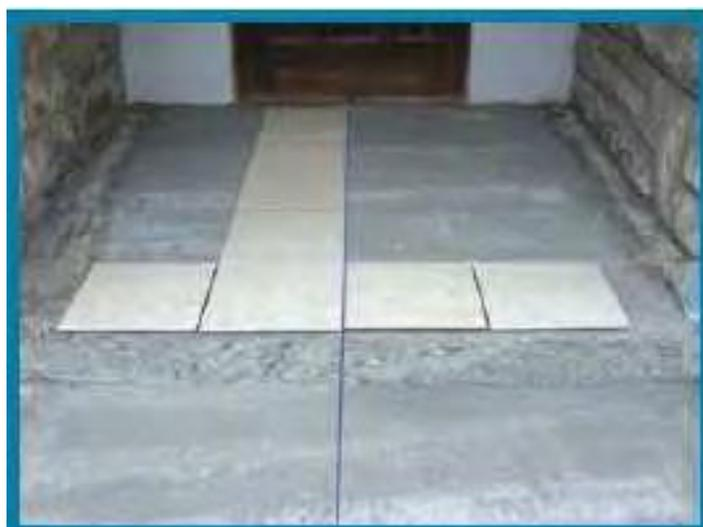
considerando, además, el ancho de la junta a utilizar. Si el espacio sobrante entre la pared y la última pieza, es inferior al tamaño de una pieza completa, correr el centro de tal manera que el corte de las piezas del extremo de un muro sea igual al corte del extremo del muro de enfrente.
